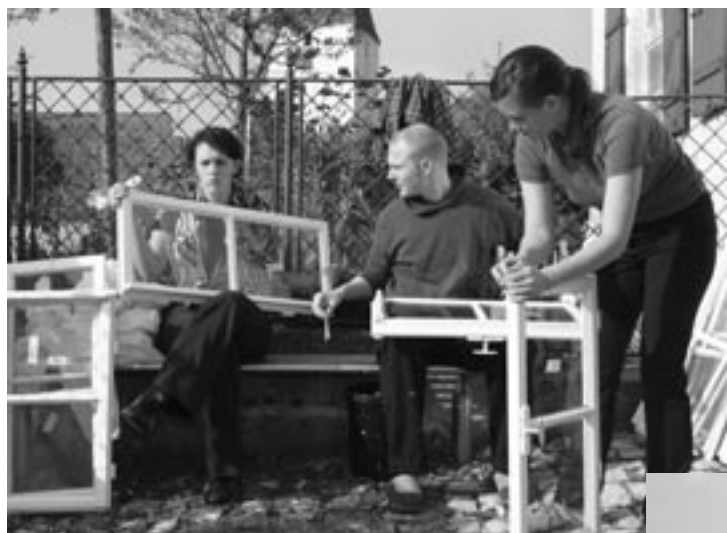
Bei strahlendem Sonnenschein konnte im Freien gearbeitet werden und die frisch lackierten Fenster trockneten schnell. Was für ein Glück für uns und die senegalesischen Gäste! So konnte auch der zweite Anstrich (deuxième couche) noch aufgebracht werden
