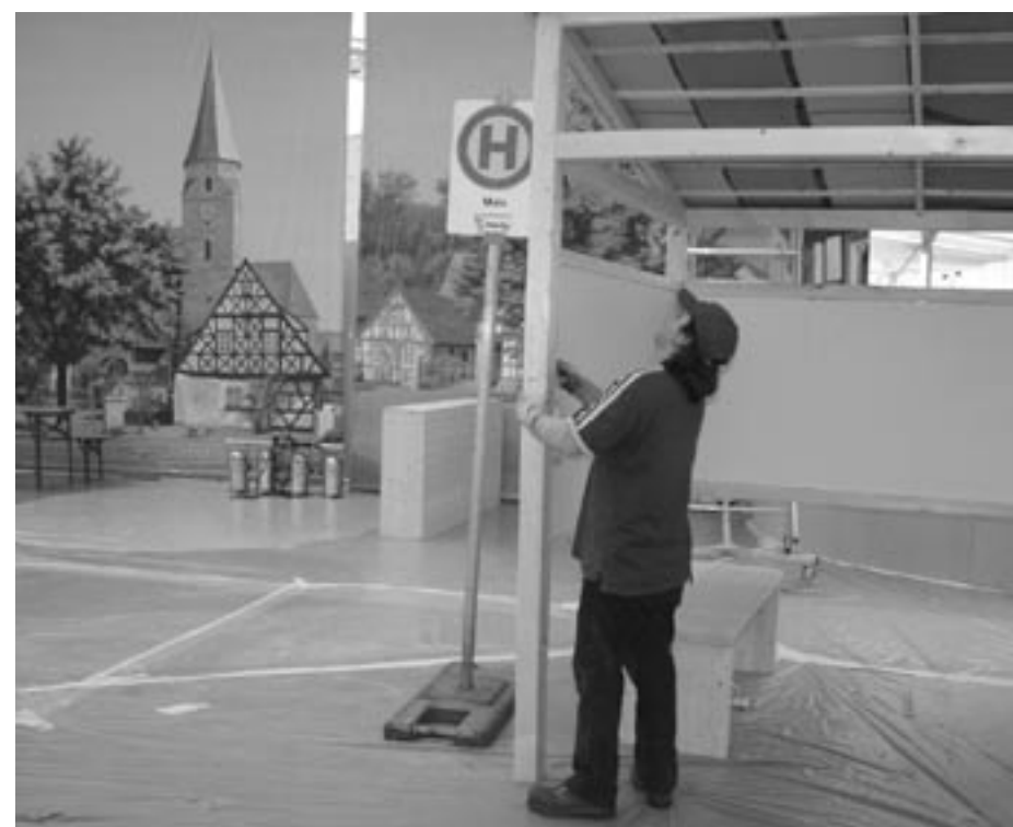
Arbeiten am Bushäuschen in Halle 9 - dem Stand der KLJB auf dem ZLF
